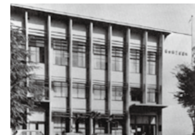
仙台商工会議所新会館(昭和31年)
