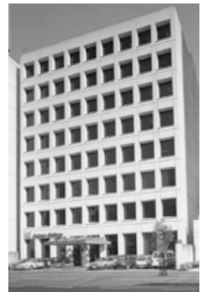
仙台商工会議所新会館(昭和55年)
