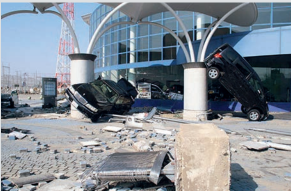
津波で被災した夢メッセみやぎ。(仙台市宮城野区)
