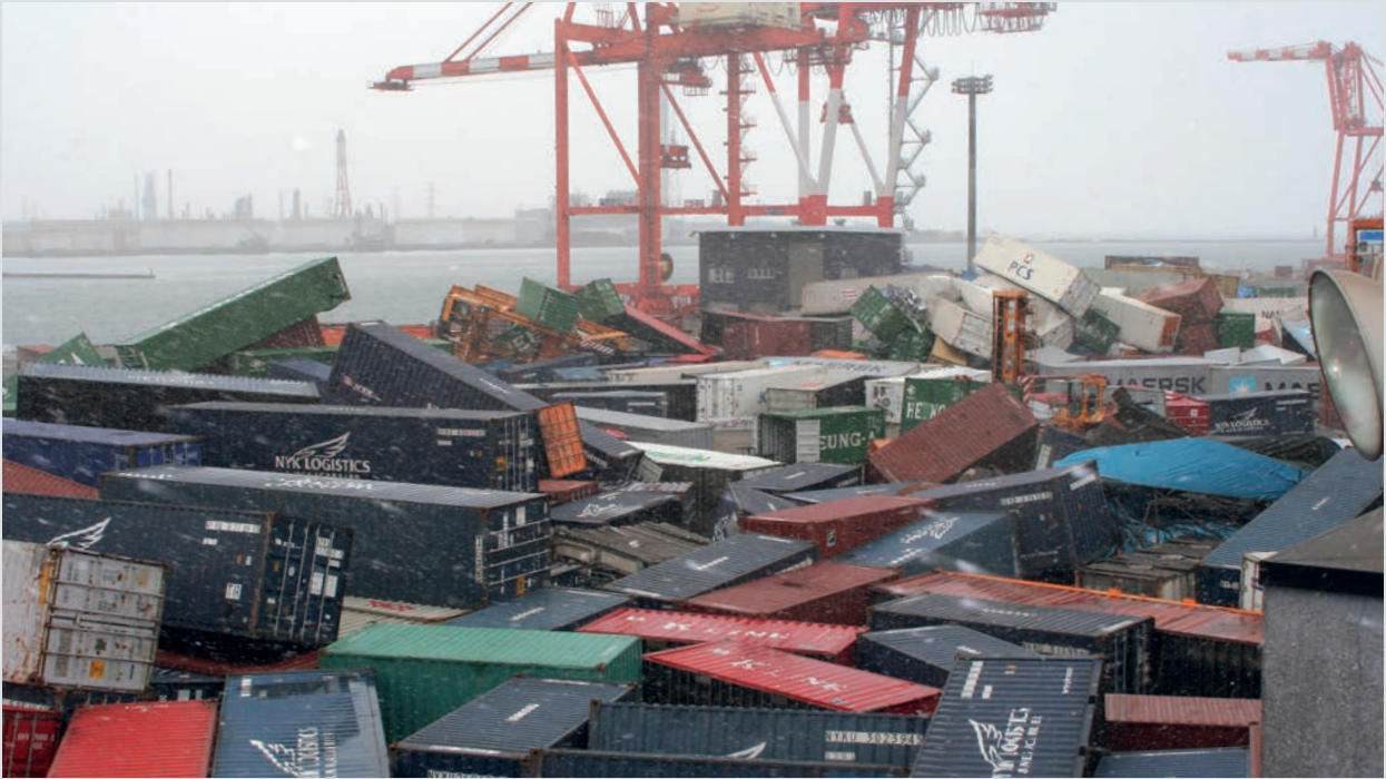
整然と積み上げられていたコンテナが無残に崩れた仙台港の高砂コンテナヤード。(仙台市宮城野区)
