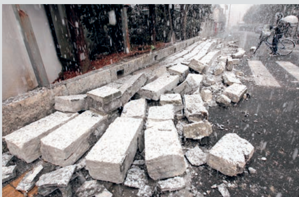
住宅街では激しい揺れで石塀も倒壊した。
