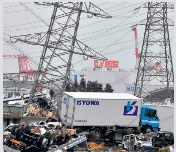
送電線の鉄塔が傾き、トラックが折り重なる仙台港付近。(多賀城市)
