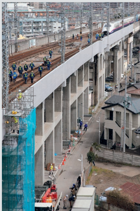
地震で損傷した東北新幹線の高架柱の復旧作業。 全線運転再開は2011年4月29日まで及んだ。(仙台市宮城野区)
