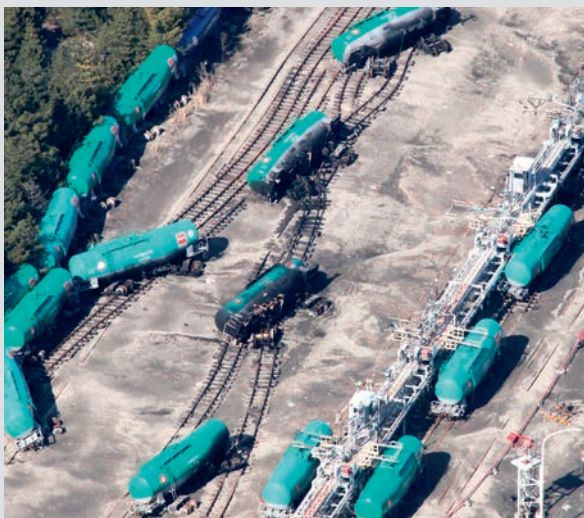
製油所の敷地内では引込線のレールが歪み、タンク車が横転した。(多賀城市)
