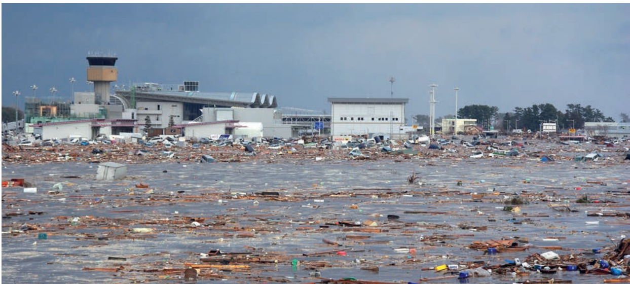
津波に飲まれた仙台空港(仙台航空基地屋上から撮影)
